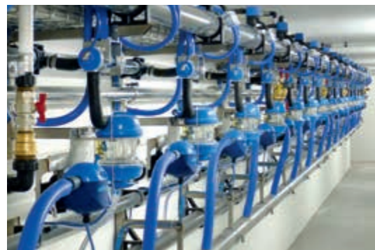
Impiantistica nel tunnel Subway installation
